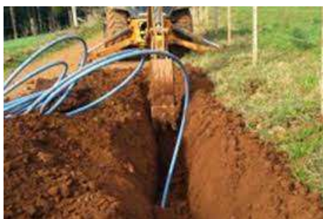
Figura 5-6 – Detalhe instalação do tubo na rede
